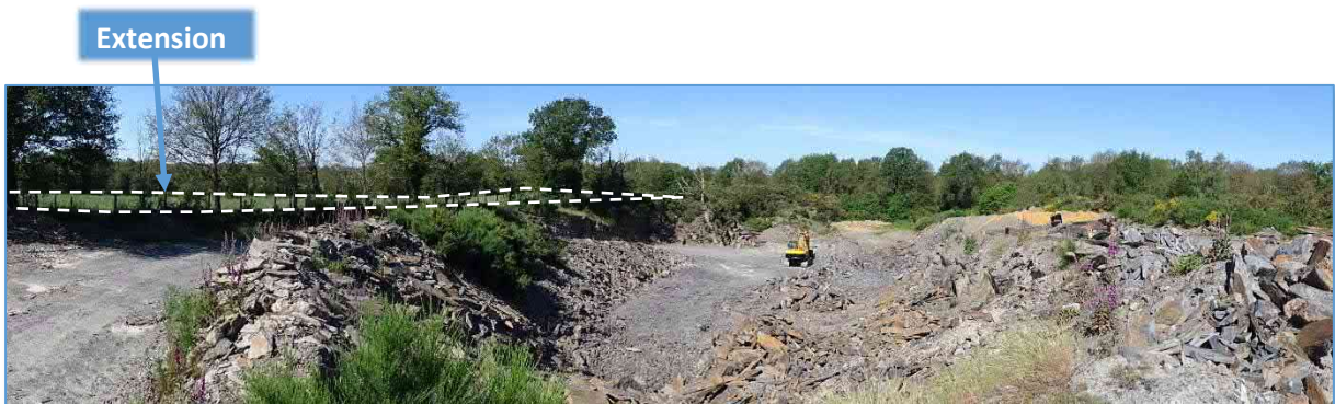
Fig. 2 : Vue B : zone d'extraction depuis l'Est
