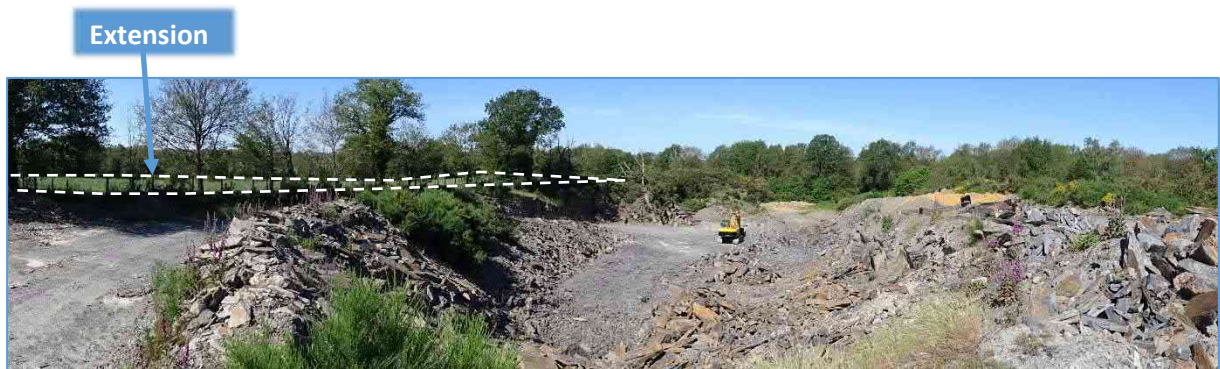
Fig. 2 : Vue B : zone d'extraction depuis l'Est
